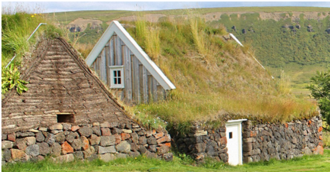
Byggðasafn Skagfirðinga og Fornverkaskólinn hafa um árabil kennt handverkið við torfhleðslu, torfskurð og -ristu. Þekking á handverkinu er m.a. nauðsynleg til að viðhalda torfhúsum landsins. Mynd af lifandihefdir.is
