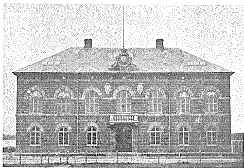
Alþingishúsið, reist 1881. Árið 1905 voru þrjú söfn í Alþingishúsinu: Listasafn Íslands, Landsbókasafn og Þjóðskjalasafn. Þar hafi einnig Forngripasafnið verið til húsa frá 1881 til 1899, en áður hafði það verið geymt á Dómkirkjuloftinu, 1863 til 1879 og í hegningarhúsinu 1879 til 1881. Þess má geta að Náttúrugripasafnið var í húsi Geirs Zoega á Vesturgötu 10 frá 1903 til 1908. Eftir mynd í ibid. , bls. 33.
